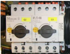
Abb. 1: Motorschutzschalter
